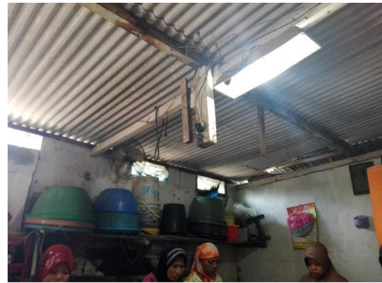
Gambar 3. Ruang proses yang tidak sesuai dengan SSOP
