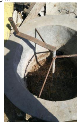
Gambar 1. Digester Tidak Beroperasi
