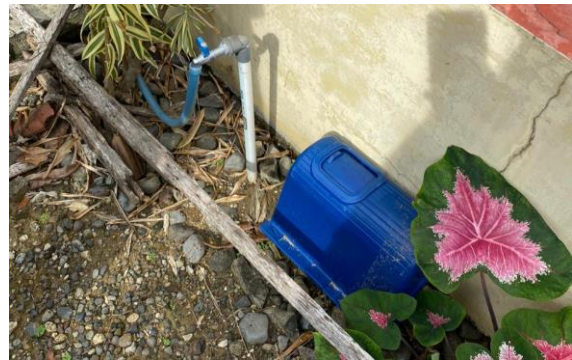
Gambar 10. Kondisi Eksisting Saluran PDAM Di setiap Rumah
