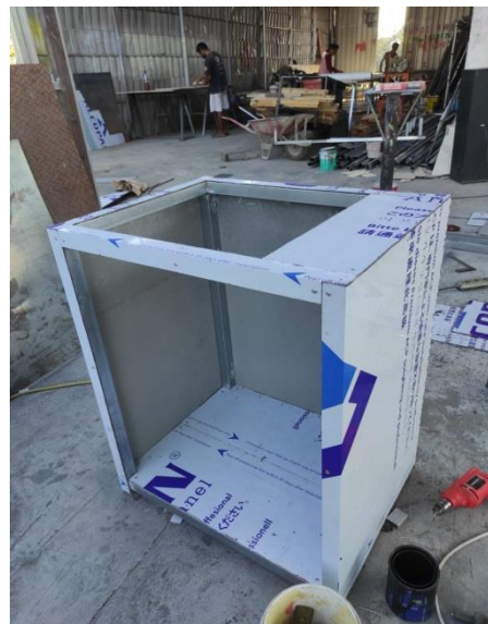
Gambar 4. Proses Pemasangan Kerangka
