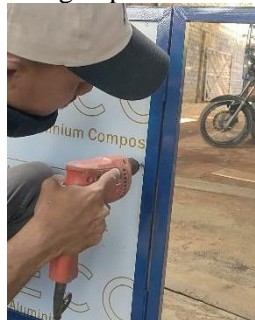
Gambar 11. Proses Pemasangan Pemotongan Aluminium Composite Panel (ACP)
