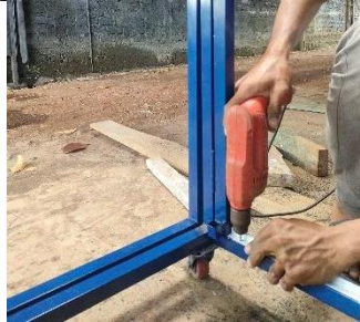
Gambar 9. Proses Pemasangan Lis Siku
