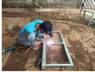
Gambar 5. Proses Pemasangan Engsel
