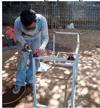
Gambar 6. Proses Pemasangan Engsel
